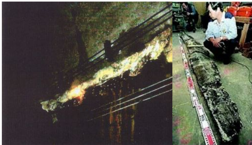
北九州トンネル (H11.10) JR西日本提供
