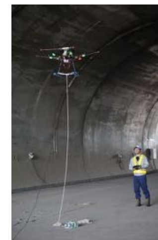
ロボットによる打音検査
