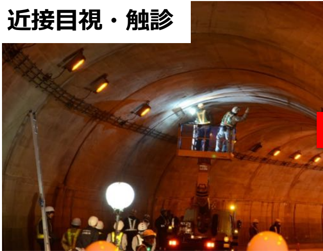
奈良県 戸ヶ坂トンネルの点検(2016. 3.4)
