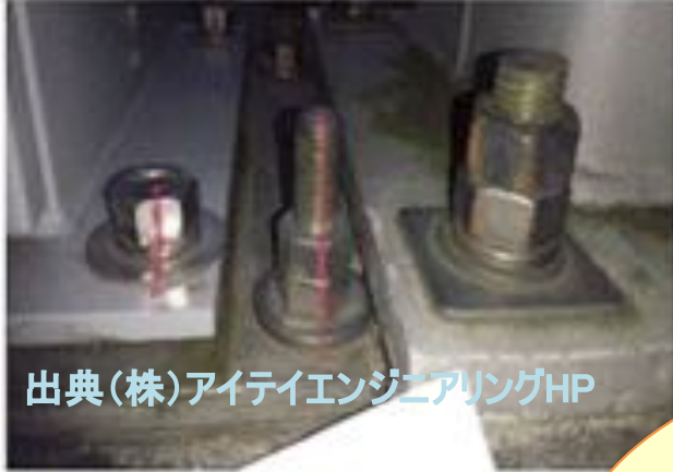
屋内・屋外設備機器の点検
