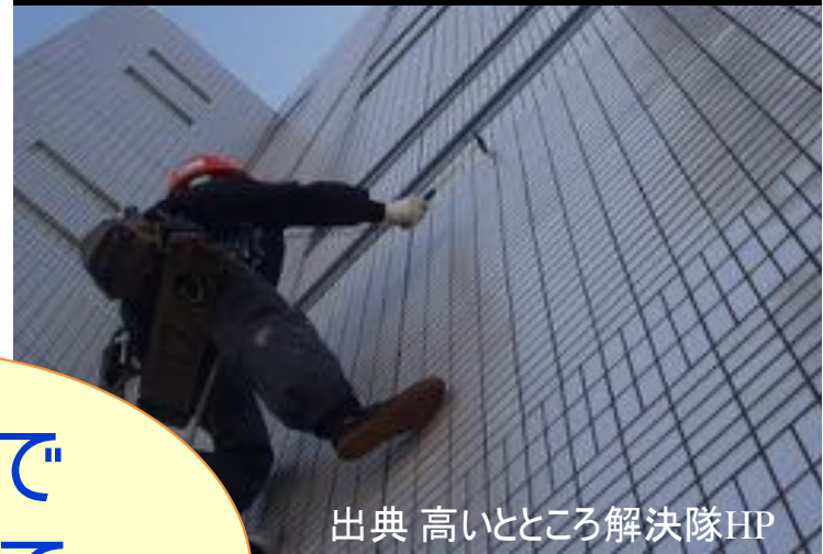
ビルの外壁パネル検査
